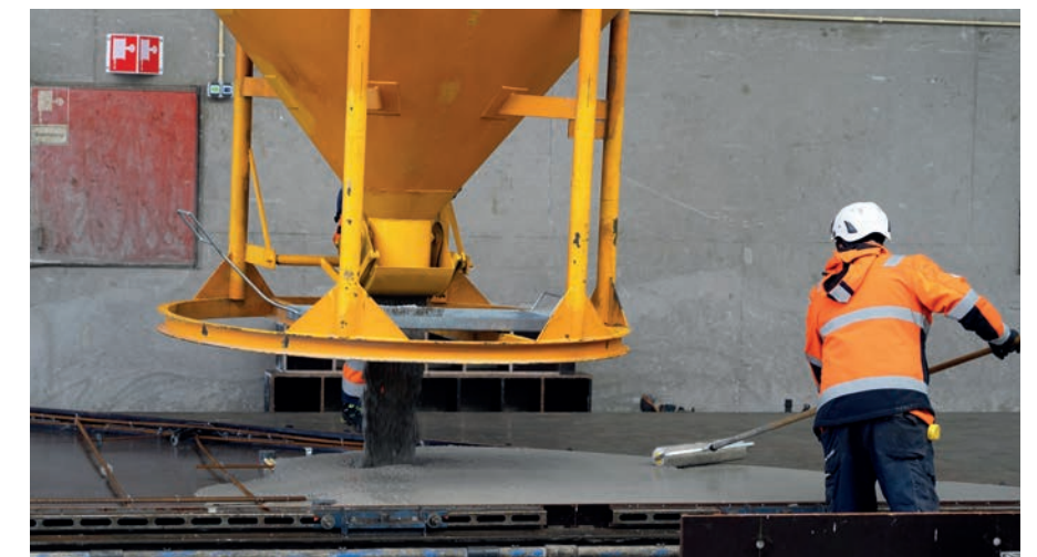
Betonstort voor prefab elementen bij Van Wijnen Smart Structures I.
