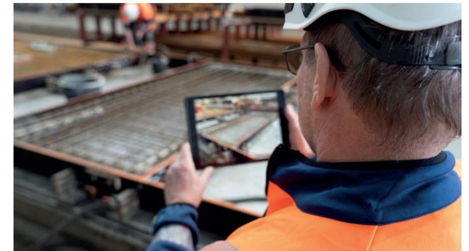
Bij Van Wijnen Smart Structures I heeft de controlemedewerker een eigen tablet met daarop de BIM4Production-app.
