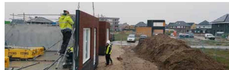
Plaatsing van een prefab wand.
