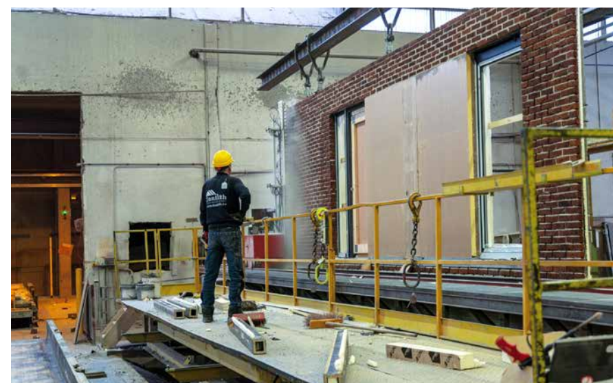
Geprefabriceerd element gereed voor de laatste afwerkingen.
